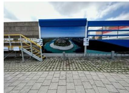
Die Hersteller der Lärmschutzelemente präsentieren, was in Sachen Gestaltungsmöglichkeiten derzeit aktuell und machbar ist. So zierte das Mühldorfer Stadtwappen die Anliegerseite einer Betonwand und ein Foto der Innschleife bei Mühldorf wurde über mehrere Aluminiumelemente hinweg großformatig aufgedruckt.
