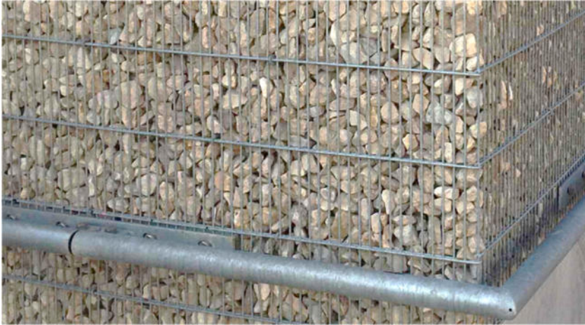
1.3.3 Eckausführung an freier Kopfseite bzw. Wandabwinklung
