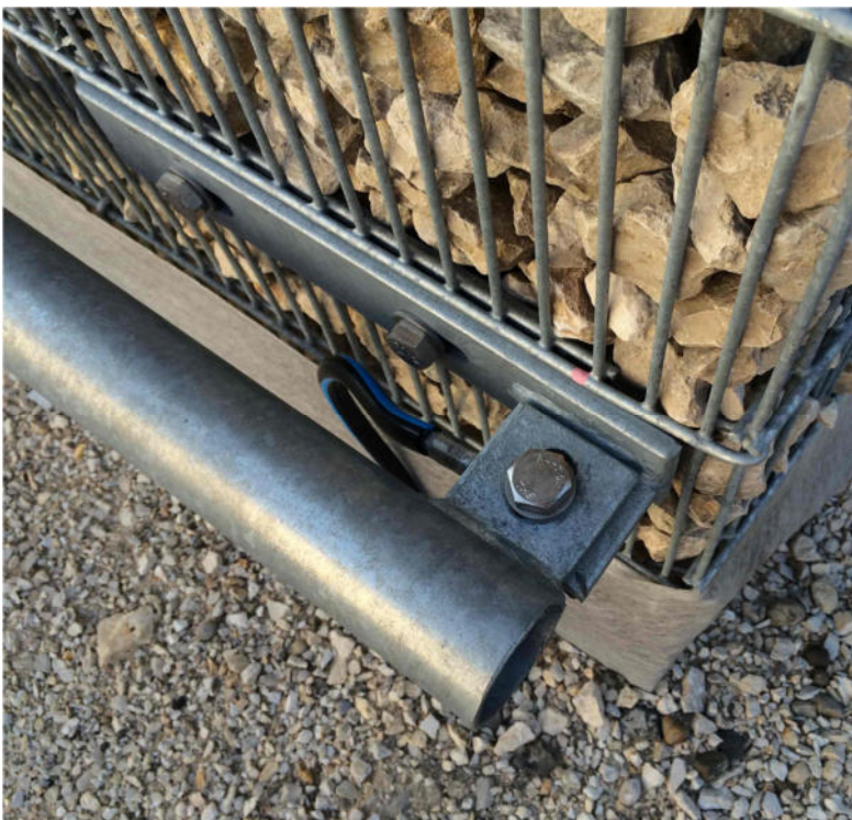
1.3.4 Prellrohrende mit Erdungsanschluss, kurze Deckplatte
