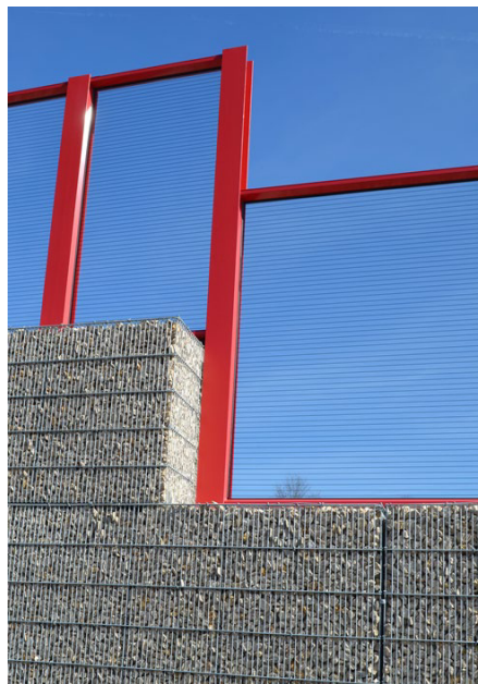
Bild 5: Kombination Gabione / transparente LSW
