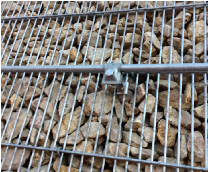
1.2.1 Befestigungsklammer, ca. 1,50 m
