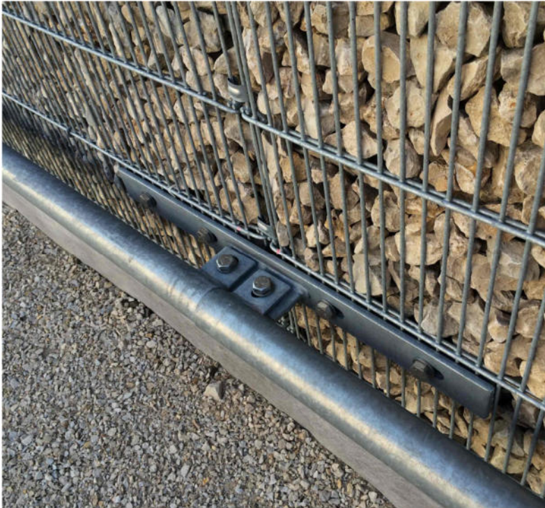
1.3.1 Prellrohrbefestigung an FS-LSW (von oben)
