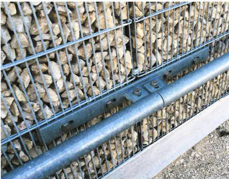
1.2 Prellrohr, Befestigung an innenliegenden Konterplatten
