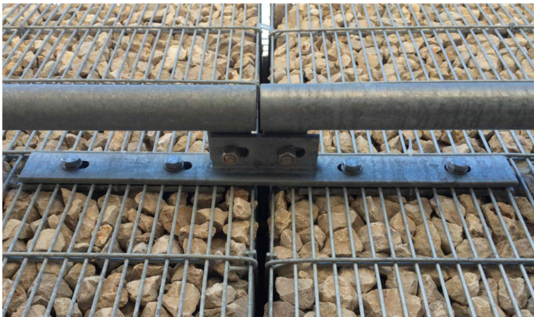
1.3.2 Prellrohrbefestigung an FS-LSW (von unten)
