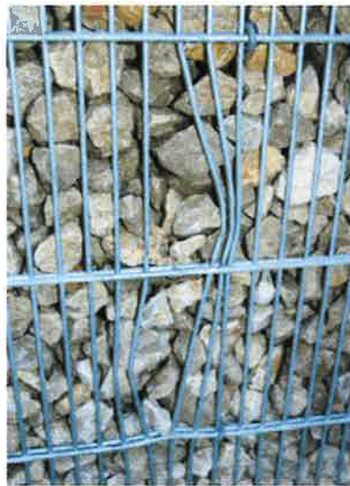
Bild [3] Mechanische Verformung der Gitterstäbe
