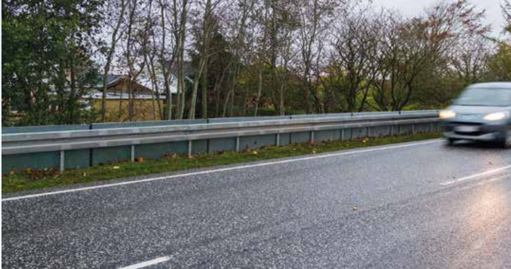
Bild 1: Die Hauptbauteile der Lärmschutzplanke sind ein perforierter Schutzplankenholm und die mit Mineralwolle gefüllten Absorptionselemente
