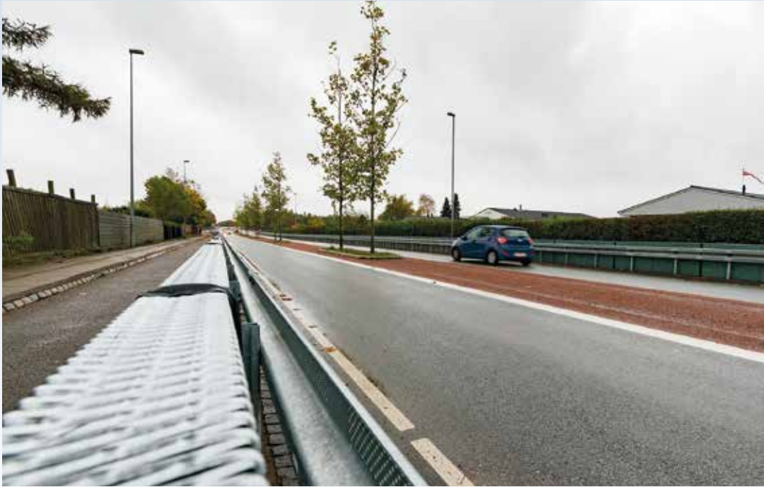
Bild 2: Mit der Lärmschutzplanke steht eine Lärmschutzeinrichtung kombiniert mit einem Fahrzeugrückhaltesystem zur Verfügung, das die Aufhaltestufen N2, H1 und L1 gemäß EN 1317-2 erfüllt
