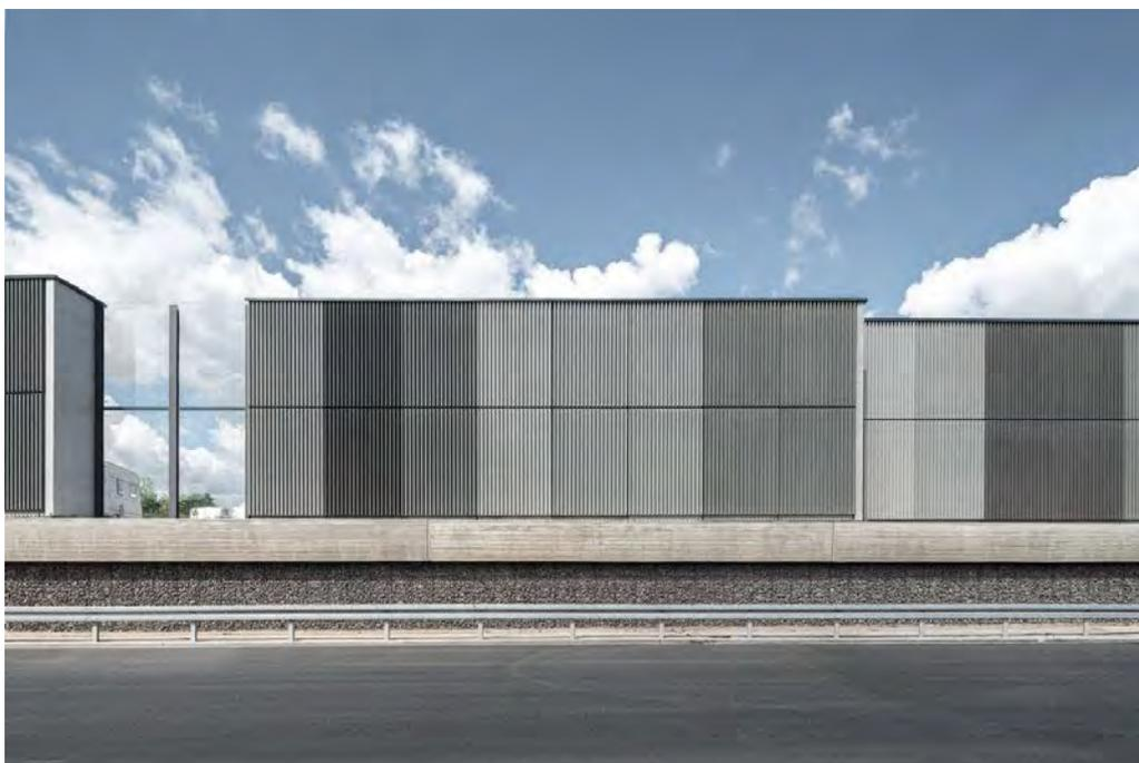
**Bild 1** F.C. Nüdling Fertigteiltechnik lieferte Lärmschutzelemente aus haufwerksporigem Beton in verschiedenen Grautönen für die Autobahn A 3 im Bereich von Würzburg Heidingsfeld.
