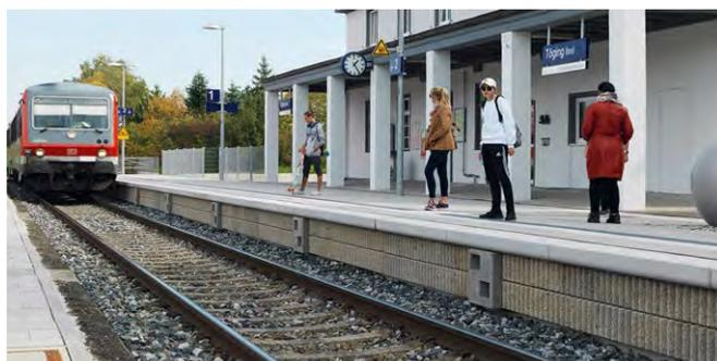
**Bild 3** Die hochabsorbierende Bahnsteigkante mit ihren integrierten Absorberkörpern entwickelte Leube speziell für den Einsatz an Haltestationen und Bahnhöfen mit dem Ergebnis reduzierter Lärmreflektion z. B. beim Einfahren eines Zuges.
