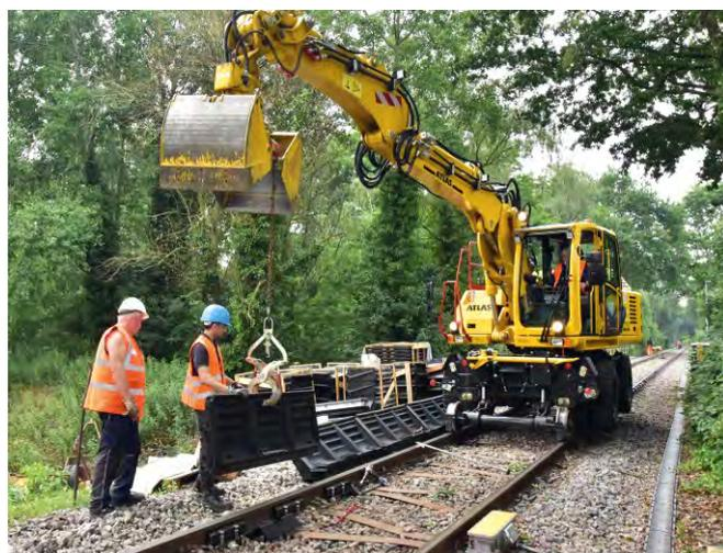
**Bild 3** Die Mini-Schallschutzwand mSW\_360 von STRAILlastic wurde mit Hilfe eines Zwei-Wege-Baggers eingebaut.
