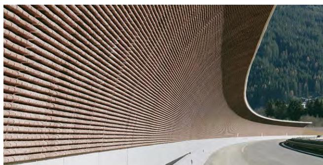
**Bild 1** Durch die Form von bogenförmigem Lärmschutz liegt die Beugungskante näher an bzw. über der Lärmquelle. Somit können Schallabschirmungen erzielt werden, die ansonsten nur mit Tunnel bzw. Einhausungen erreicht werden. Die wirtschaftliche Alternative zu Einhausungen und Galerien (bis zu 80 % Kostenersparnis).
