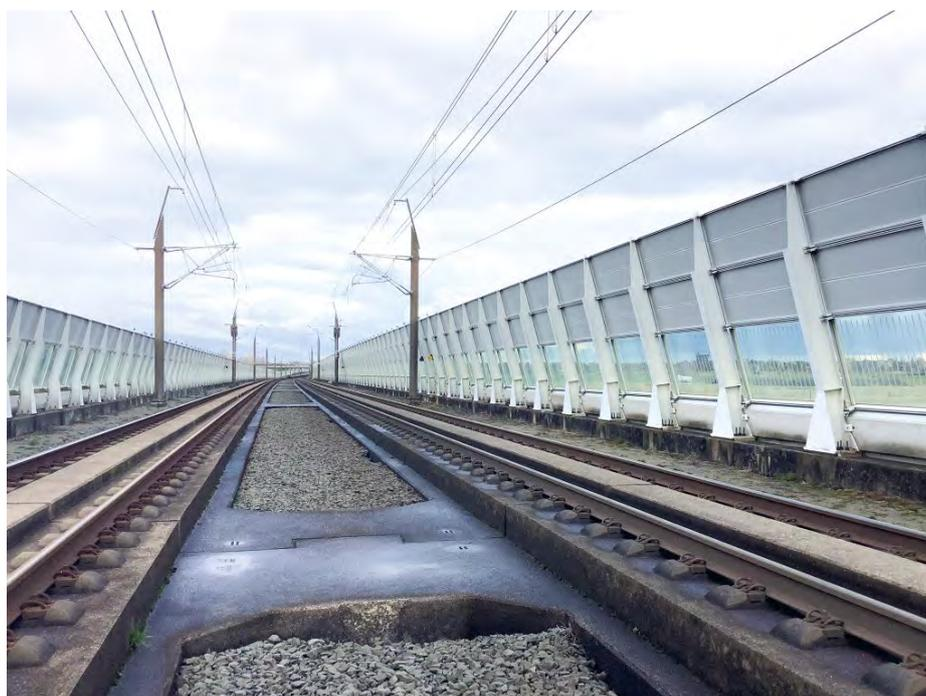
**Bild 1** Die ausgeklügelte Kombination von hochabsorbierenden mit transparenten Elementen ...
