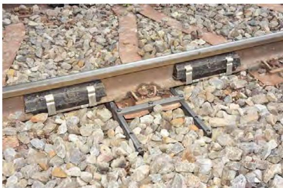
**Bild 2** In den Schwellenfächern des Gleises wurden rund 950 Schienenstegdämpfer STRAILlastic\_A inox 2.0 verbaut.
