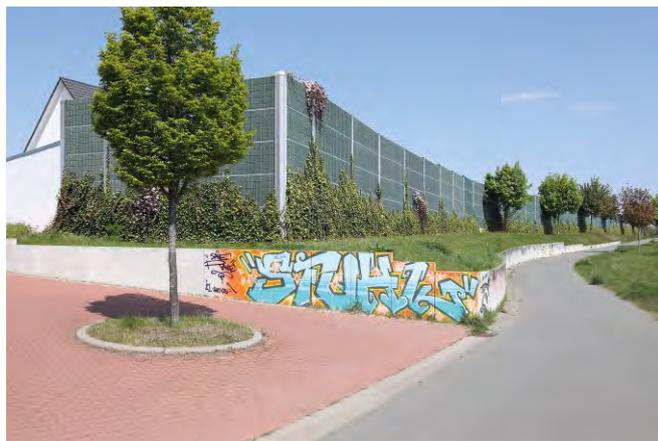
Bild 5 Während die Winkelstützmauer Graffiti nicht entging, gibt die Lärmschutzwand das gewünschte Bild.
