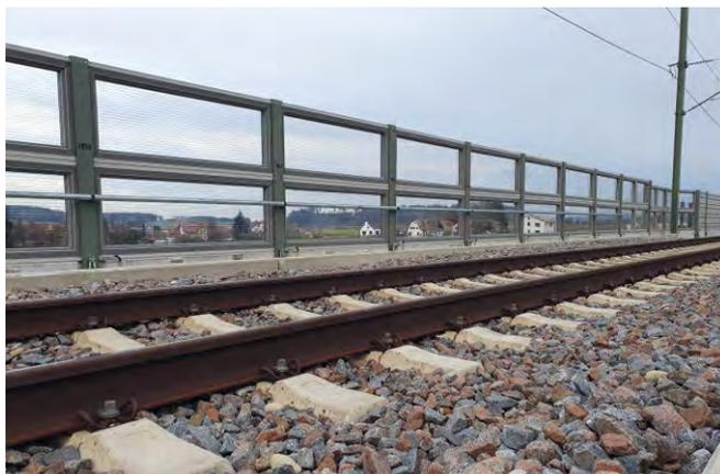
**Bild 3** Lärmschutzwand auf der EÜ Hauptstraße in der Gemeinde Westerheim. Zum Einsatz kamen erstmalig transparente absorbierende Elemente (TAP-Rail), um einerseits die Sichtachse der beiden Ortsteile aufrecht zu erhalten und gleichzeitig die negativen Schallreflexionen beim Einsatz transparenter Elemente zu minimieren.
