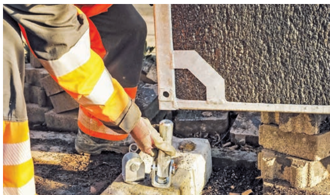
Bild 2 Die Montage mittels Steckverbindungen ist mühelos nach Anleitung auch durch Dritte möglich.
