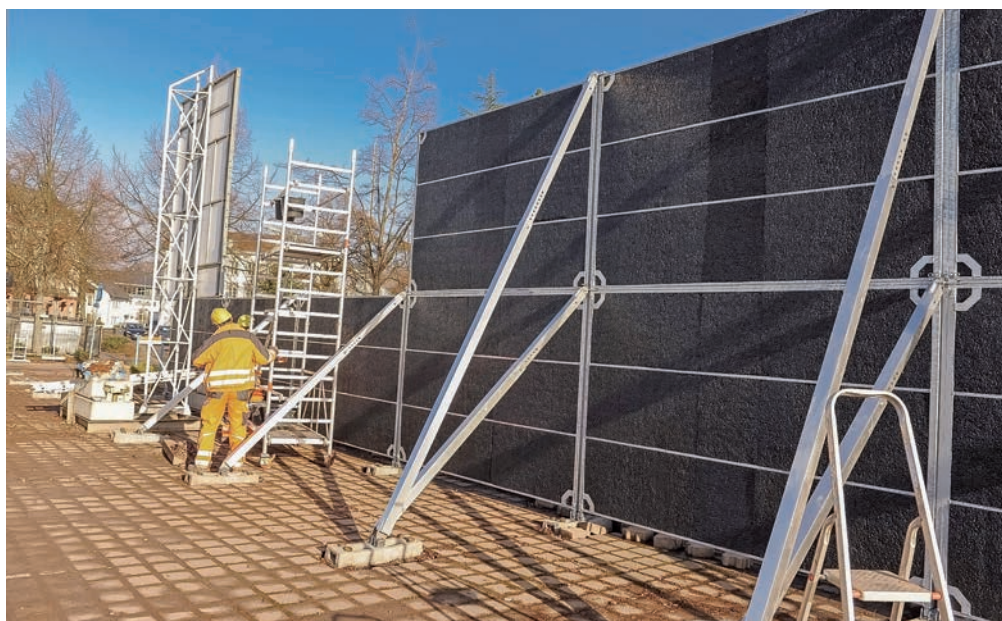
Bild 3 Schnelle und einfache Montage der temporären Lärmschutzwand in Merzig
