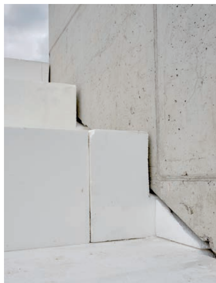
Bild 2 Die AirPor-Blöcke werden nach Maß gefertigt und in verschiedenen Größen geliefert. Auf der Baustelle spart das den Verarbeiter jede Menge Zeit.
