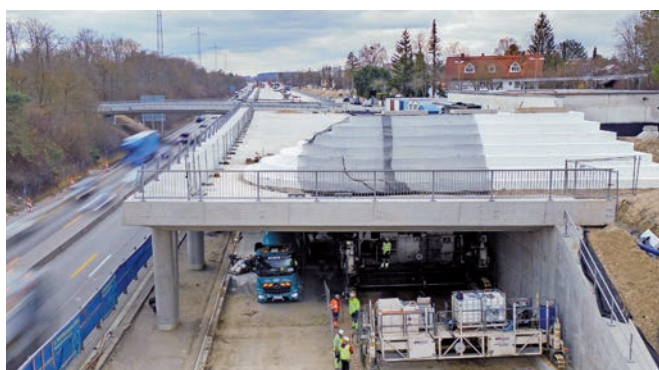
Bild 1 Die Lärmschutzwälle aus dem innovativen Dämmmaterial AirPor von JOMA sollen die neuen Galerien nahe Germering und Gilching lückenlos mit ebenfalls neuen Lärmschutzwänden entlang der Autobahn A96 verbinden.
