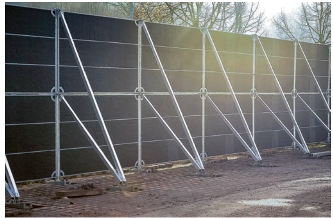
Bild 4 Baustellenansicht: Befestigung mittels Schrägabstützung auf Betonfüßen mit Erdnägeln
