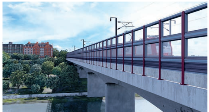
Bild 2 TAP-Rail eignet sich wegen seiner hohen Steifigkeit auch für Hochgeschwindigkeitsstrecken (bis 300 km/h)
