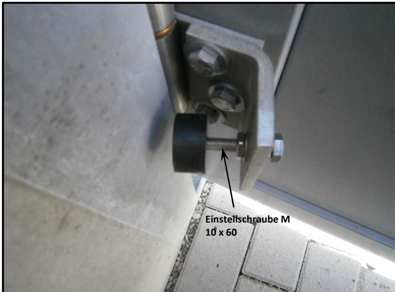
Türstopper im Auslieferungszustand ( ohne jegliche Einstellung )
